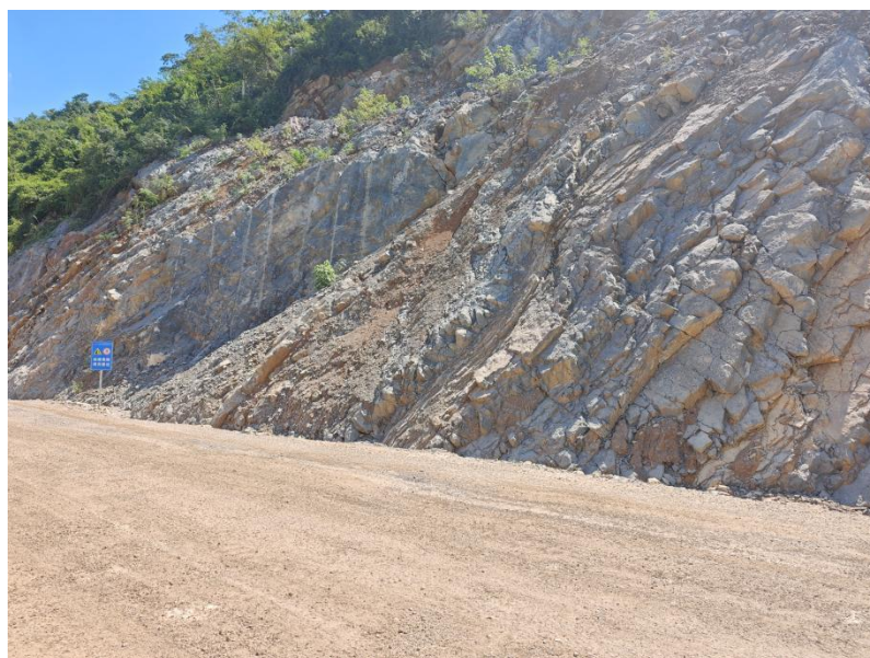
照片 3-3 矿山道路边坡现状（一）
