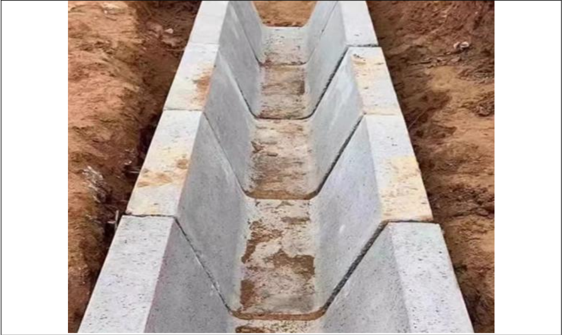
图 4-4 预制砼 U 型排水沟示意图
