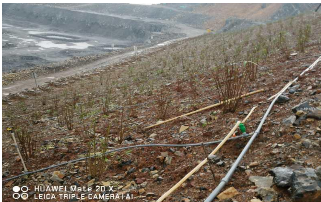
照片 2-4 边坡绿化喷淋系统
